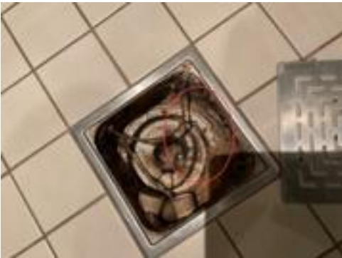
Hovedsluket i dusjsonen.
