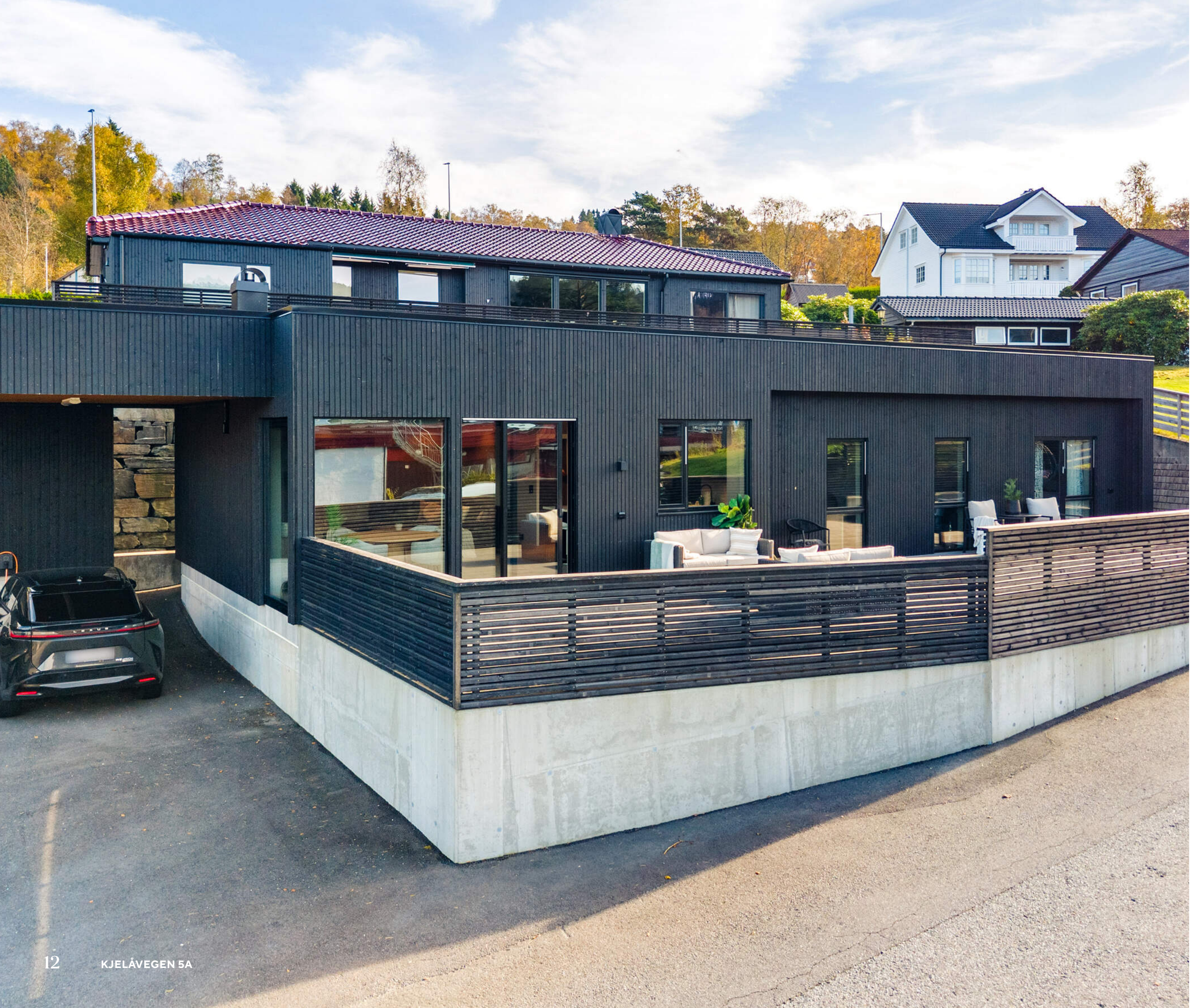
Bygningssakskyndig Morten Soltvedt (befaringsdato: Mandag, 21. september 2026)
