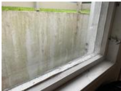
Eldre vindu med koplet glass i kjeller.
