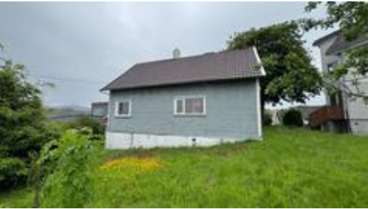
Originalbygg kan være der vindu til høyre slutter.
