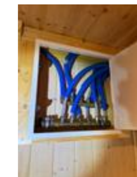
Rørskap i bod med sluk uten avrenning.
