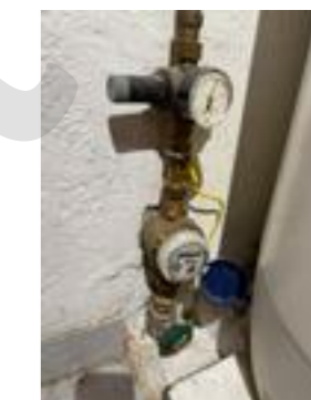
Rørskap i bod med sluk uten avrenning.
