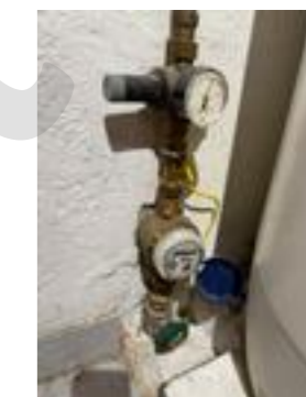
Rørskap i bod med sluk uten avrenning.
