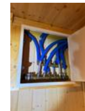
Rørskap i bod med sluk uten avrenning.
