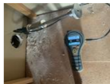
Måling med pigger i trevirke viser akseptabelt nivå.
