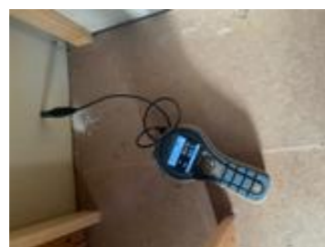
Måling av RH i hulrom viser akseptabelt nivå.
