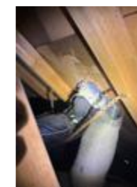
Misfarging ved gjennomføringen til ventilasjon
