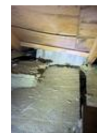
Misfarging ved gjennomføringen til ventilasjon
