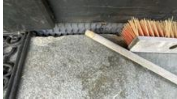
Grunnmursplast som utvendig fuksikring, synlig enkelte steder.
