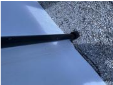
Takvannet ledes til rør i grunnen
