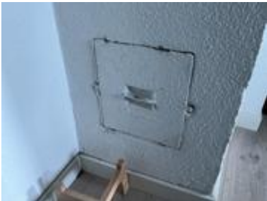
Sotluke i underetasjen
