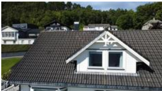
Taket er tekket med betongstein
