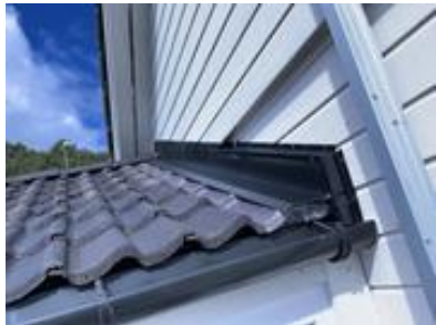
Beslaget er ført opp utenpå bordkledningen
