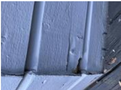
Mindre råteskader på kledningen ved sammenføyning på karnapp
