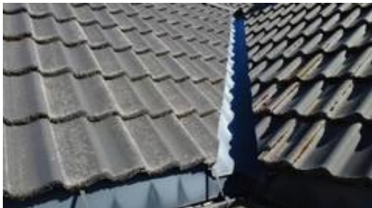
Taket er tekket med betongstein
