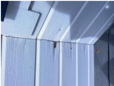
Mindre råteskader på kledningen ved sammenføyning på karnapp
