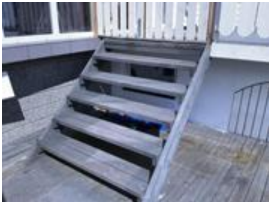
Trapp av tre mellom terrasse og veranda
