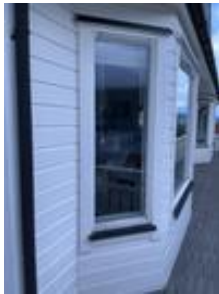
Vinduer med karmen av tre og isolerglass
