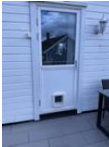
Nedre del av dørbladet på verandadør sør har noe slitasje
