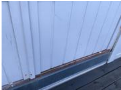
Nedre del av dørbladet på verandadør sør har noe slitasje
