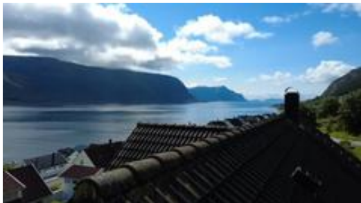
Taket er tekket med betongstein
