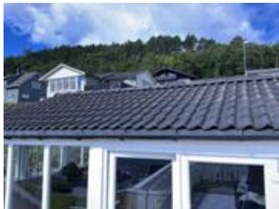
Taket på hagestuen er tekket med betongstein.
