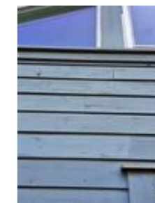
Noe værslitt og sprekk i bordkledning
