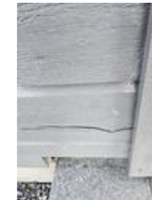
Noe ufagmessig avslutning i innerhjørner
