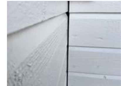
Noe ufagmessig avslutning i innerhjørner
