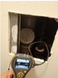
Utført kontroll i tiliggende konstruksjon - Fuktmåling
