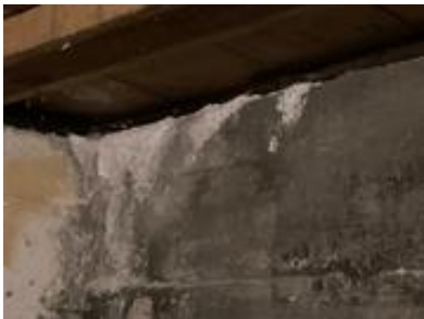
Målt fukt i nedre trappevange mot bakvegg
