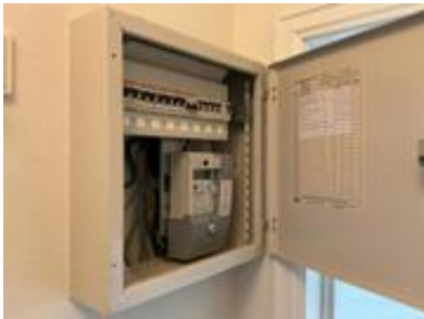
Sikringsskap med automatsikringer og kursfortegnelse
