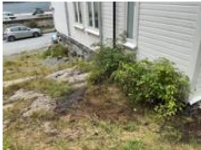
tynt jorddekke over berggrunn mot øst
