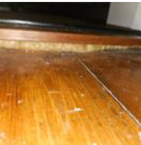
Tetting med fugeskum under brannklassifisert entredør
