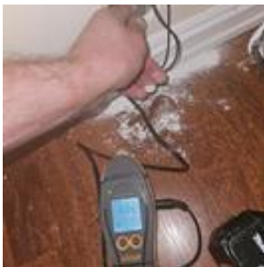
Ingen indikasjon på unormal fukt i veggen
