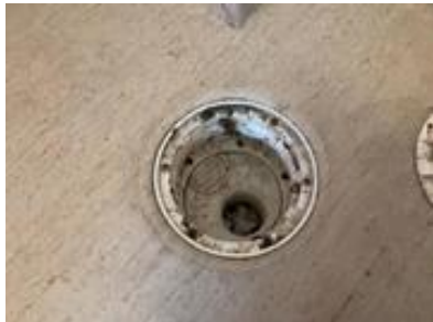
Gulvbelegget er klemt mot en plastsluk i gulvet
