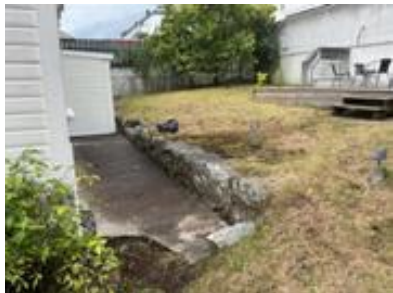
Støpt dekke mot nord
