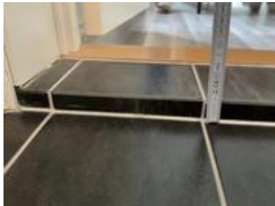
Det er etablert en oppkant under døren som ekstra sikring mot lekkasje
