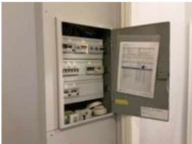
Sikringsskap med automatsikringer og kursfortegnelse
