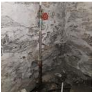
Galvanisert stålrør fra kjelleren og ned i grunnen
