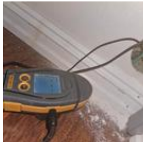
Ingen indikasjon på fukt i veggen
