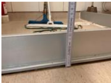
Tettelisten rundt dusjnischen er høyere enn overkant av tettesjiktet foran døren
