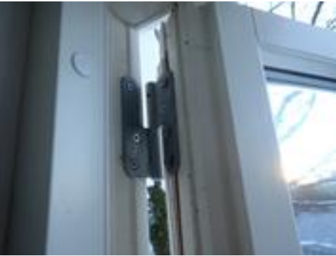
Innfesting til hengslene er løs som følger av skader i karmen.
