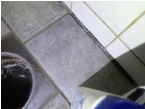
Misfarget fugemasse i dusjsonen og silikonfuge glipper litt.
