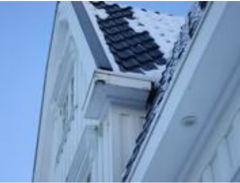
Lokal råteskade/værslitasje på treverk, det er tilsvarene på motsatt side av takutstikket.
