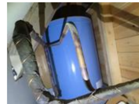
Eldre bereder lokalisert i knevegg.
