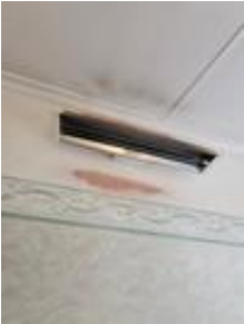
Skade på vinylbelegg og i takplate
