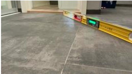
Øvrige gulv har fall mot sluk.
