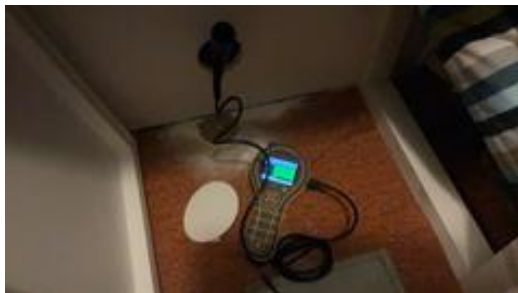
Fuktmåling i grønn sone, ingen fuktutslag.
