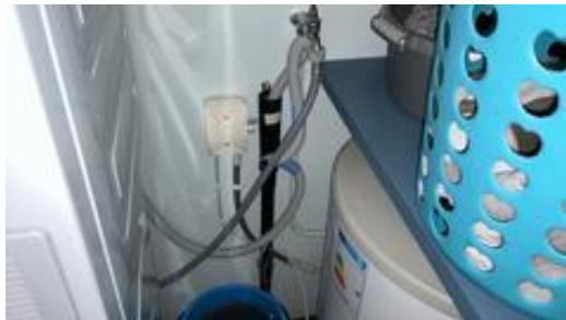
Forskriftsmessig koblet bereder med bryter.
