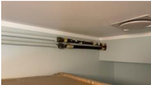
Vannledninger av kobber/ stål, fra byggeår.
