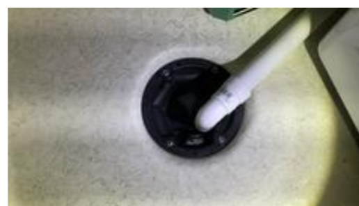
Sluk i gulv.
