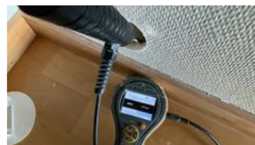
Hulltatt/fuktsøkt i vegg uten unormale forhold.
