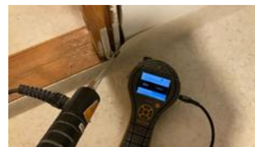
Fuktsøkt i skillevegg mot vaskerommet uten unormale forhold.
