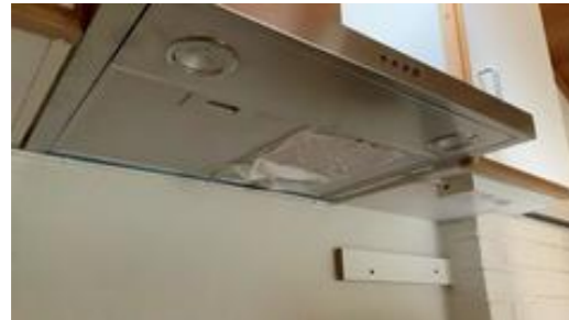
Ventilator funksjonstestet med papir.
