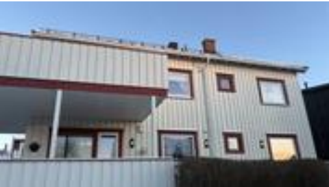
Bildet viser at det kun er etablert snøfanger på deler av taket og at det er en takstige som kun er festet med bøyle over mønet.
