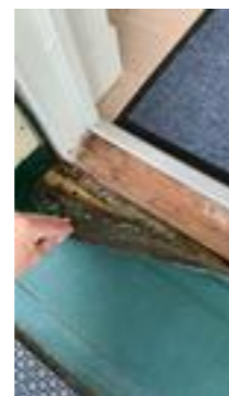
Begynnende fukt / råteskade på kledningen på innsiden av rekkverket
