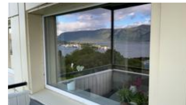
Vinduer med karmen av pvc og isolerglass
