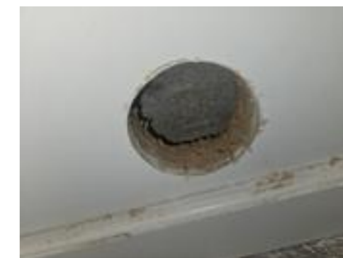
Forsøkt å borre hull, avdekket kjerne av betong i veggen
