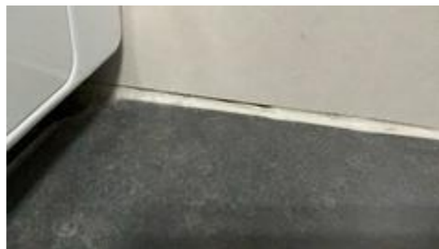
Litt slipp i en silikonefuge mellom gulv og vegg
