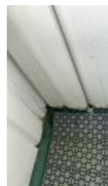
Begynnende fukt / råteskade på kledningen på innsiden av rekkverket
