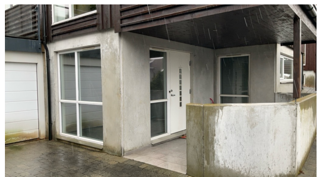
Betongelementer som grunnmur.
