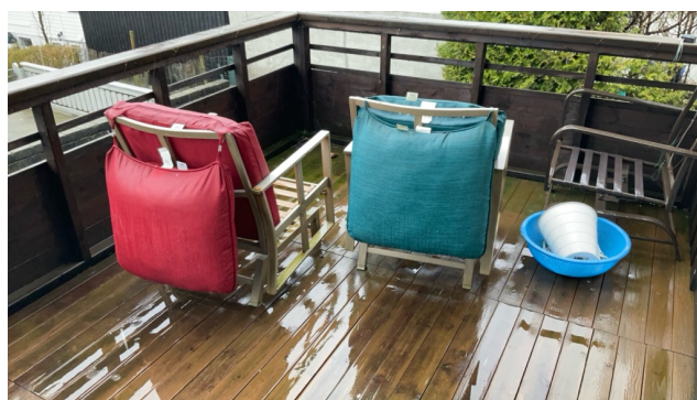
Balkong fra stue i 1 etg tekket med protan.
