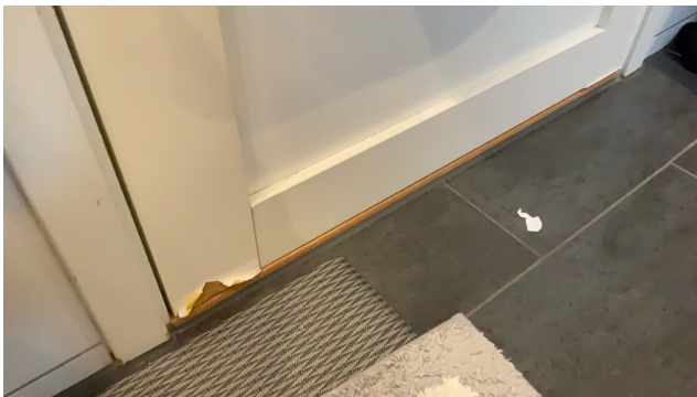
Fuktskadet dørblad.
