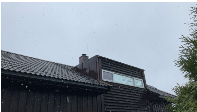
Betongtakstein og papptekking.
