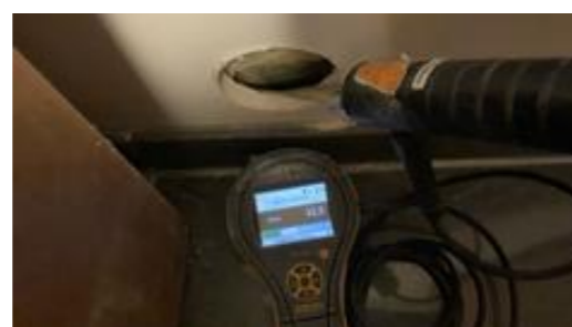
Fuktsøkt uten unormale forhold.
