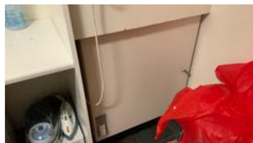
Motor for ventilasjonsanlegget
