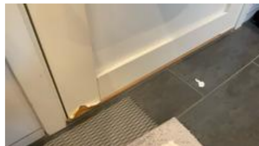
Fuktskadet dørbled.
