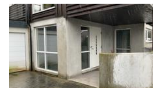
Betongelementer som grunnmur.
