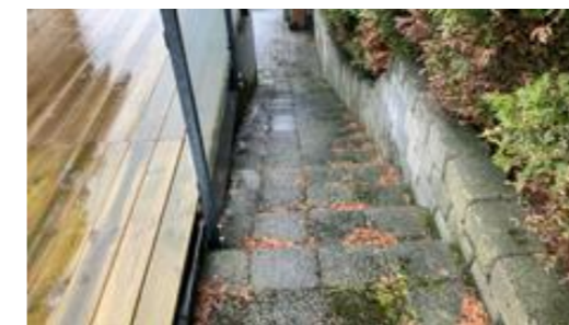
Trapp ned ved siden av garasje.
