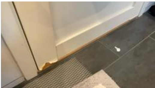
Fuktskadet dørblad.
