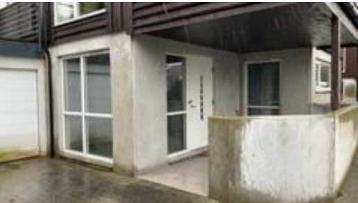
Betongelementer som grunnmur.
