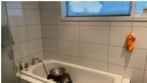
Vindu plassert i badekarets fuktzone.
