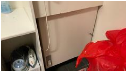
Motor for ventilasjonsanlegget
