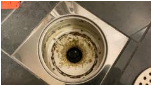
Sluk i gulv.
