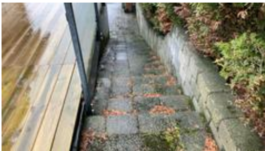
Trapp ned ved siden av garasje.
