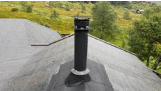
Pipe med tilhørende tekking kan være fra 2013.
