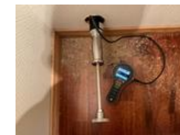
Måling med pigg i trevirke indikerer vektprosent i trevirke under 8%, som betyr at trevirket er tørt
