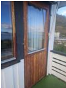
Verandadør fra soverom til veranda øst
