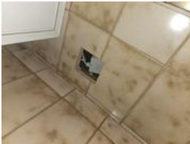
Inspeksjonsluke i veggen på badekaret
