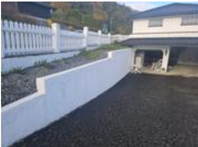
Støttemur langs innkjørselen
