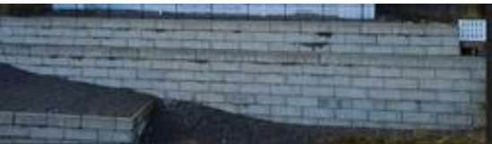
Støttemur langs tomtegrense øst
