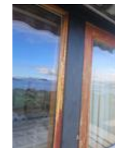
Karmene i hovedetasjen mot sør er av hardtre, teak eller lignende
