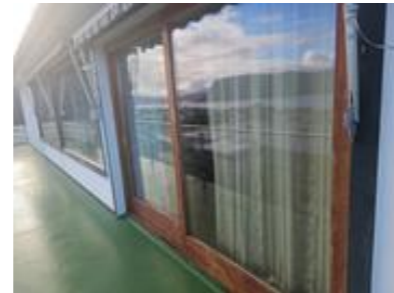
Skyvedør fra stuen til veranda øst
