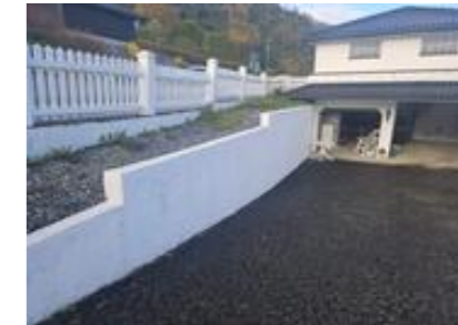
Støttemur langs innkjørselen
