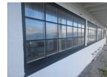
vindu kjeller, øst med koblet glass
