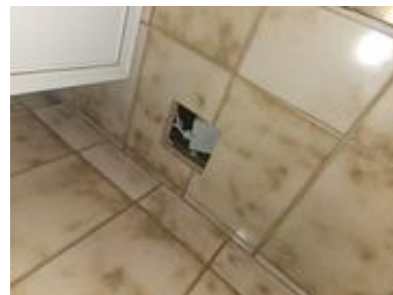
Inspeksjonsluke i veggen på badekaret
