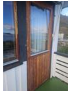
Verandadør fra soverom til veranda øst
