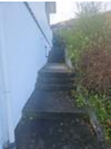
Støpt trapp langs grunnmur nord
