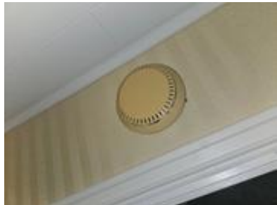
Påvist en gammel røykvarsler i hallen i 1 etg
