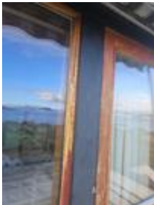
Karmene i hovedetasjen mot sør er av hardtre, teak eller lignende
