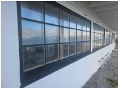
vindu kjeller, øst med koblet glass
