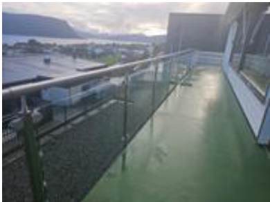
Oversiktsbilde balkong øst
