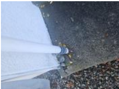
Takvannet ledes til rør i grunnen
