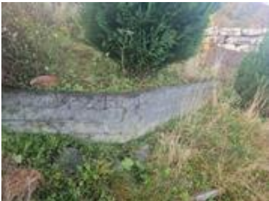
Støttemur av lettklinker i hagen har gitt etter for jordtrykk
