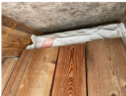
Luftespalte i takkonstruksjon.
