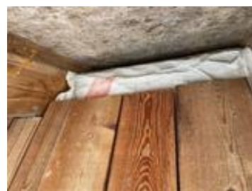
Luftespalte i takkonstruksjon.
