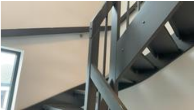
Malt tretrapp mellom etasjene.
