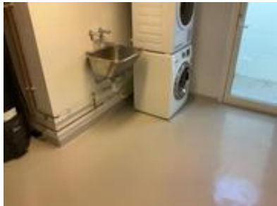
Vaskerom i kjeller.
