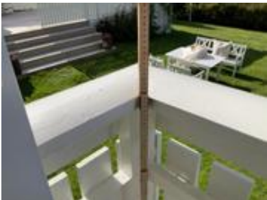
Lavt rekkverk på balkong.
