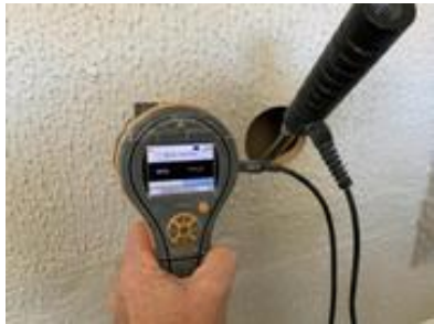
Fuktsøkt i vegg uten unormale forhold.
