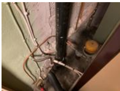
Avløpsrør i plast.
