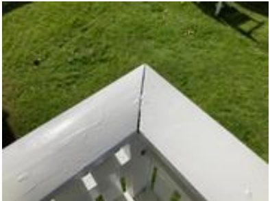
Værslitte rekke, glipe i gjæring.
