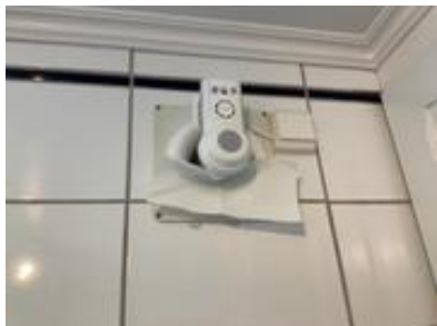
Vifte funksjonstestet med papir.
