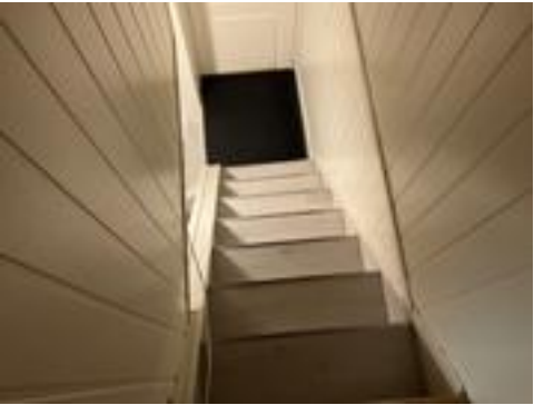
Mangler rekkverk og håndrekke.
