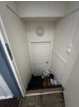
Mangler rekkverk og håndrekke.
