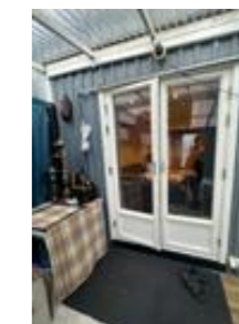
Dobbelt fløyet balkong dør med behov for justering.
