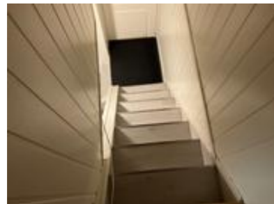
Mangler rekkverk og håndrekke.
