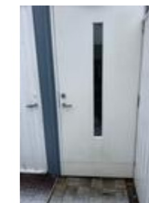
Ytterdør ned til kjeller etasjen.
