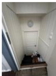
Mangler rekkverk og håndrekke.
