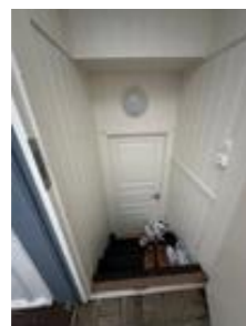
Mangler rekkverk og håndrekke.
