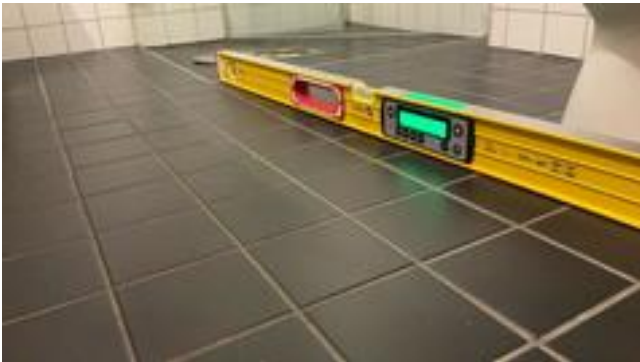
Fall er kontrollert med elektronisk vater og nivålaser.
