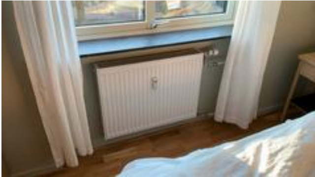
Boligen har radiatorvarme i alle oppholdsrom. Bad har vk.
