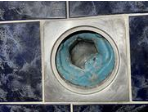
Borettslaget har utført rørfornyng i 2023.
