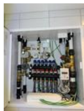
Rørskap i vegg på bad v/entre.
