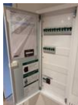
Automatsikringer med skap i entre.
