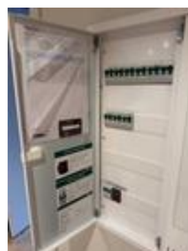
Automatsikringer med skap i entre.
