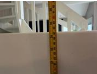
Rekkverkshøyde er under 90 cm. Avvik registrert i HMS punkt.
