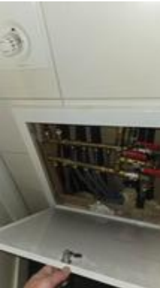
Skap på bad.
