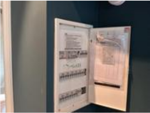
Sikringsskap med automatsikringer og kursfortegnelse
