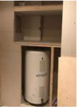
Varmtvannstanken er innebygd i en vegg på badet. Bildet er fra oppføringen av badet, tatt av tidligere eier
