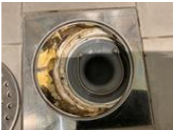
Oversiktsbilde av sluk.
