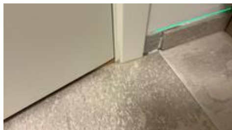
Mangler siste flis mot dørlist.
