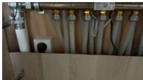
Åpning i vegg bakenfor dusjsone.
