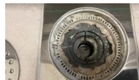
Sluk i vaskerom med synlig mansjett under klemring.
