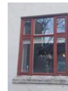
Vinduer med karmen av tre og isolerglass
