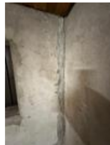
Sprekk i overgang fra tilbygg til hoveddel.
