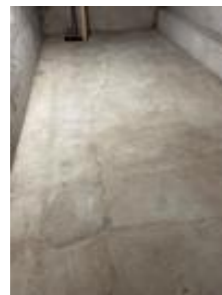
Sprekk i overgang fra tilbygg til hoveddel.
