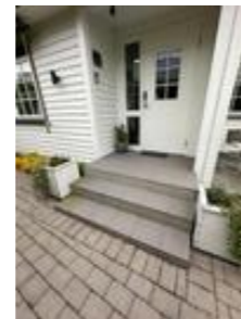
Trapp til veranda mangler håndreke.
