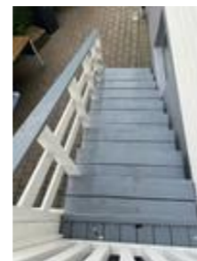
Trapp til veranda mangler håndreke.
