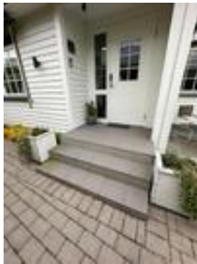
Trapp til veranda mangler håndrekke.
