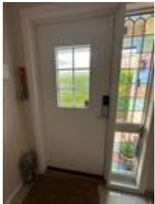
Ytterdør er skiftet ut i nyere tid.
