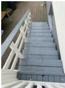
Trapp til veranda mangler håndrekke.
