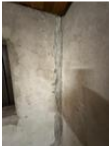
Sprekk i overgang fra tilbygg til hoveddel.
