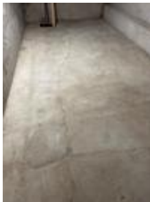
Sprekk i overgang fra tilbygg til hoveddel.
