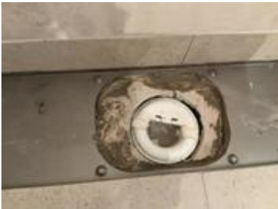
Slukrenne i dusjen
