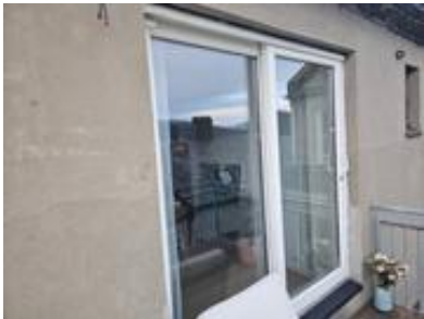
Skyvedør mot verandaen
